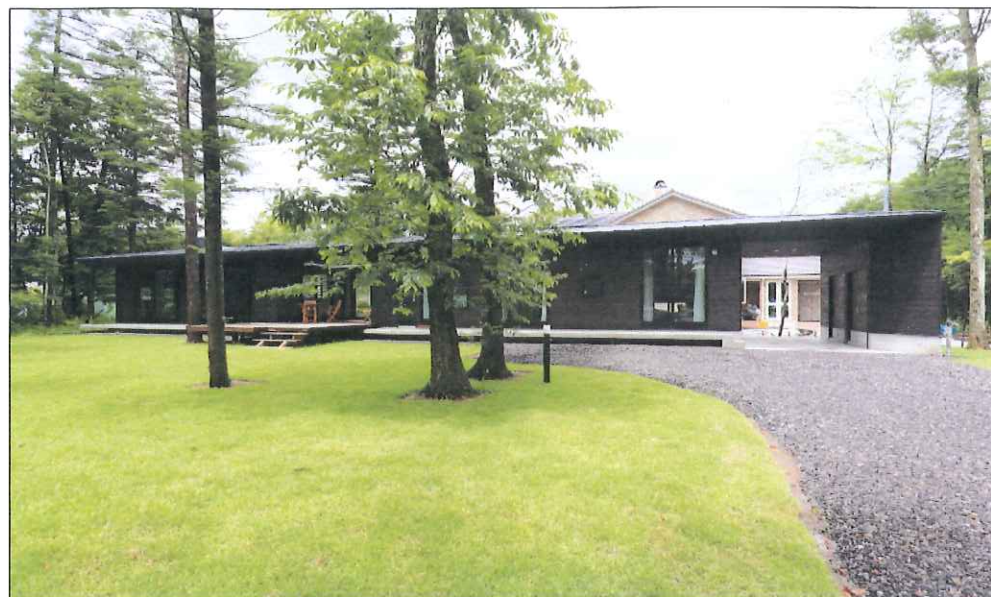
▲アプローチより建物を望む
