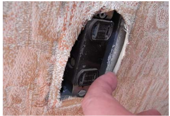
クロス下地確認
